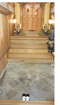
本殿から拝殿に続く石の間。これも日光東照宮と同じ造りです
